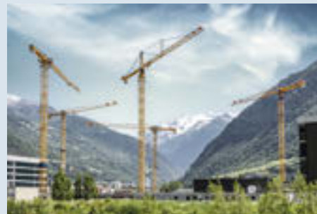
Grues à tour
